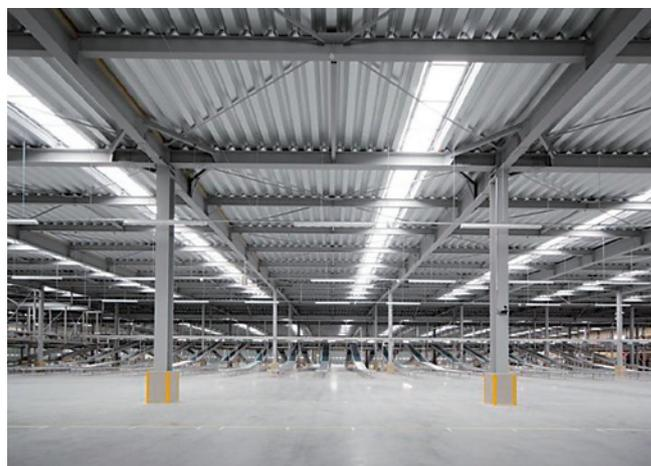
図11 照明設備全体の写真(天井のストライプ上の明かりが設置した光拡散型天窓)
